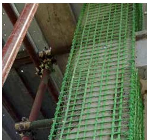
Il sistema CRM (Composite Reinforced Mortar) si compone di reti e elementi preformati in GFRP - fibre di vetro AR e resine termoindurenti - per la messa in sicurezza nonché per il miglioramento sismico e statico di opere d'arte esistenti.
